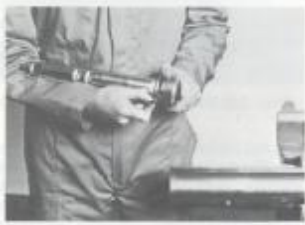
Afb. 30: Inleggen van de O-ring
