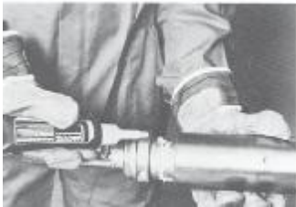
Afb. 36: Opbrengen van de lijm
