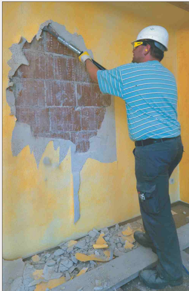
Verwijderen van pleisterwerk – zonder zich te bukken of te strekken
