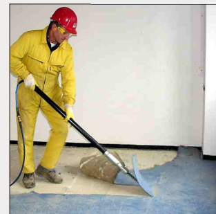
Verwijderen van vloertapijten
