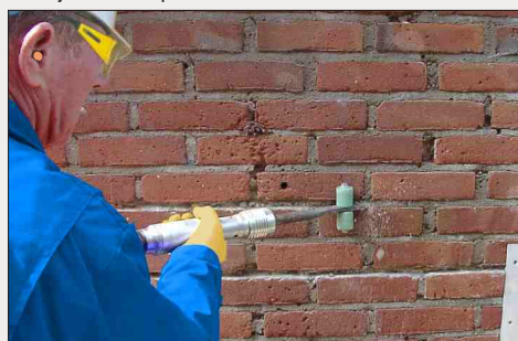
Uitkappen van voegwerk
